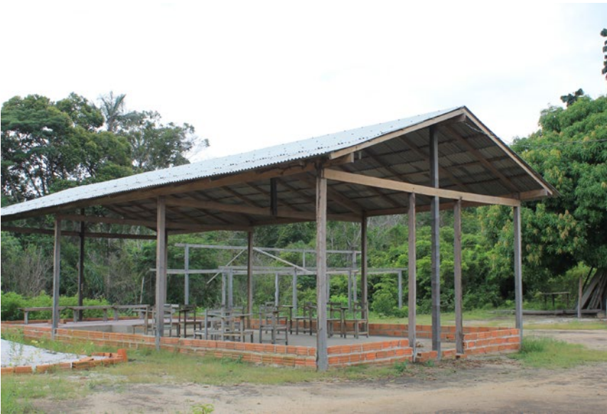
Figura 12. Casa de oração em construção, em Nova Esperança. Fonte: Trabalho de campo.
